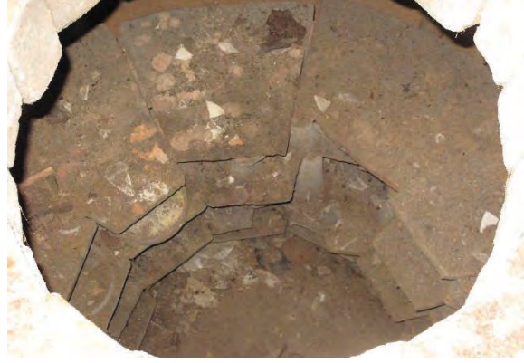
Fotoğraf: 4. Fırının Üst Kapaktan İçinin Görünüşü ve Ürünlerin Dizildiği Raflar
