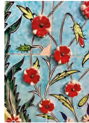
Fotoğraf: 31. Karo yüzeyinde hasar
